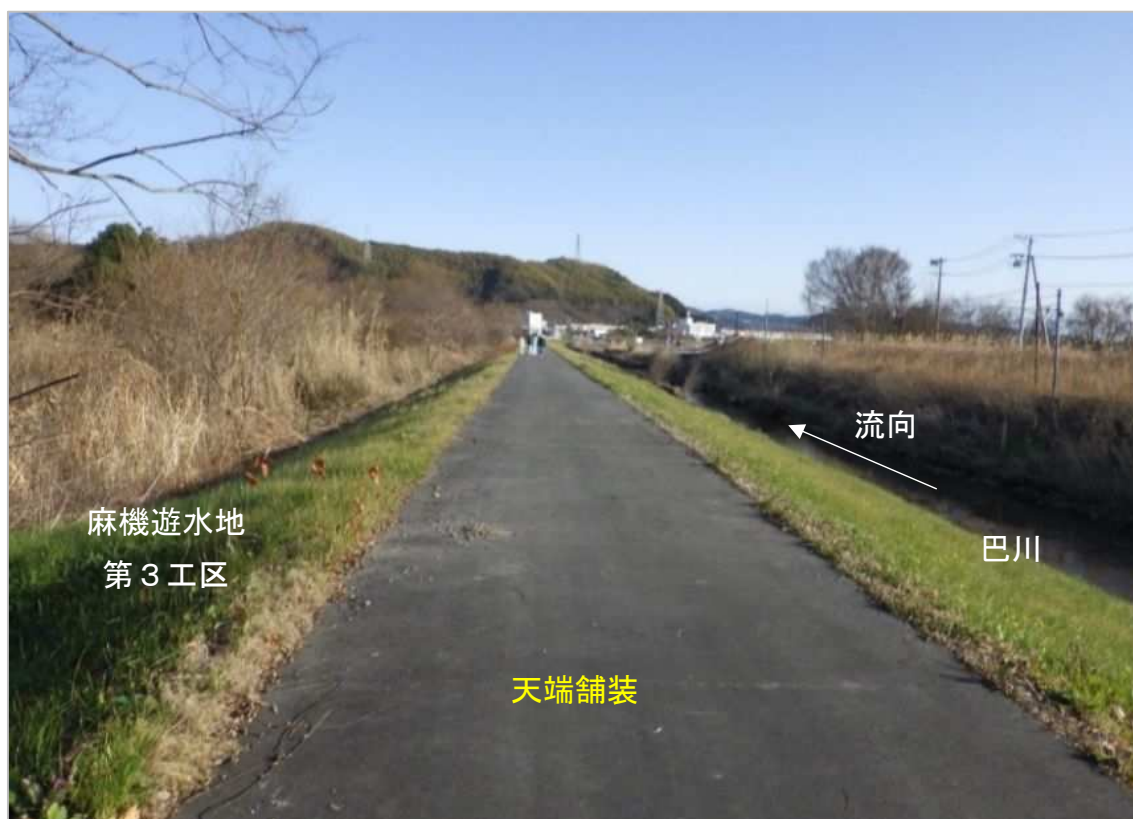
写真4：天端舗装（第3工区巴川沿い）
