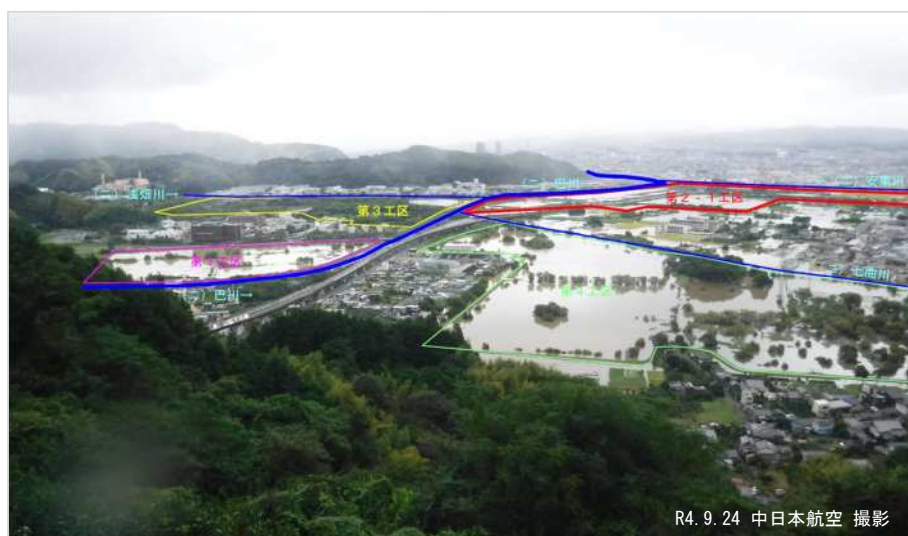
写真2：令和4年台風15号の雨を貯留した麻機遊水地
