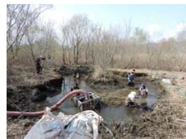
池の水抜きと底泥除去
