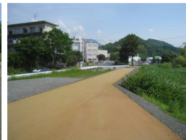
天端舗装（第3工区）
