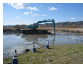
池沼部の掘削 (第3工区)
