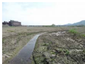
整備した水路
