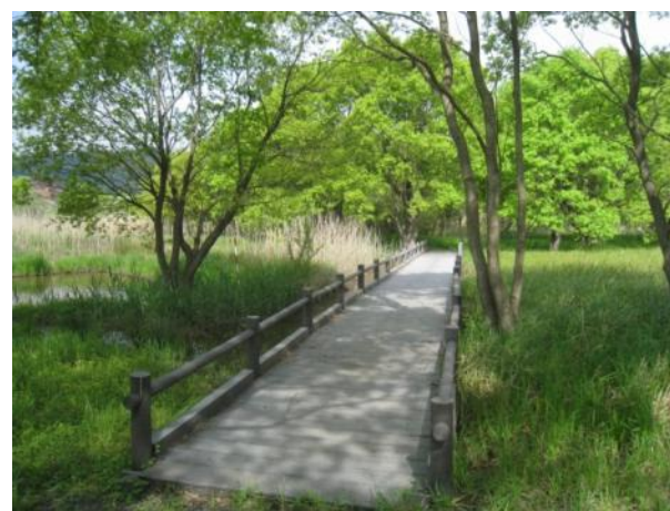
木道の整備（第3工区）
