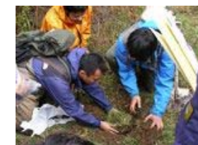
直線河川の埋め戻し作業 (釧路湿原自然再生協議会)
