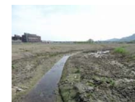
公園整備で設置した水路
