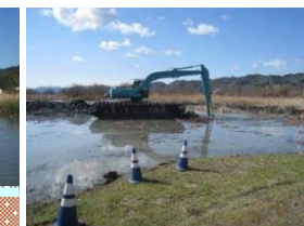
第 3 工区の池沼部の掘削
