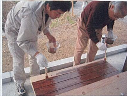
▲ 防腐剤の塗装作業
