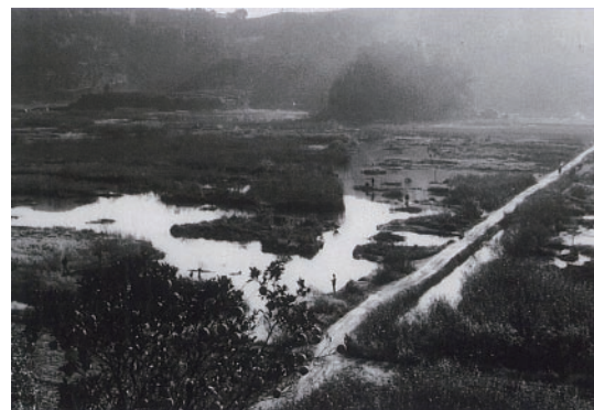
(現在の第3工区) 昭和33年頃の写真
