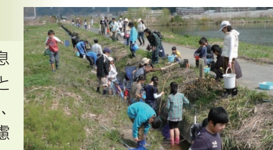
撤去する水路の魚類等の救出作業の様子
