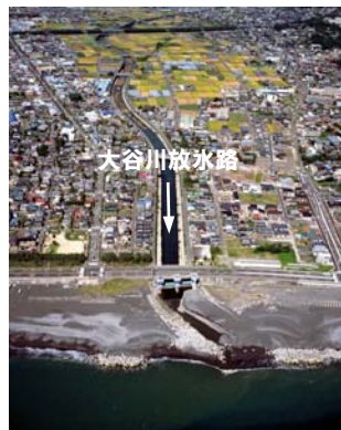
図 1-19.大谷川放水路
