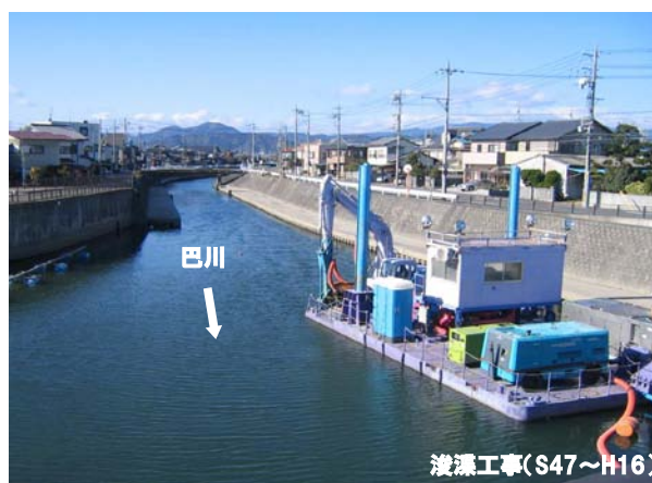
図1-27.巴川河川浄化対策（葵区古庄）
