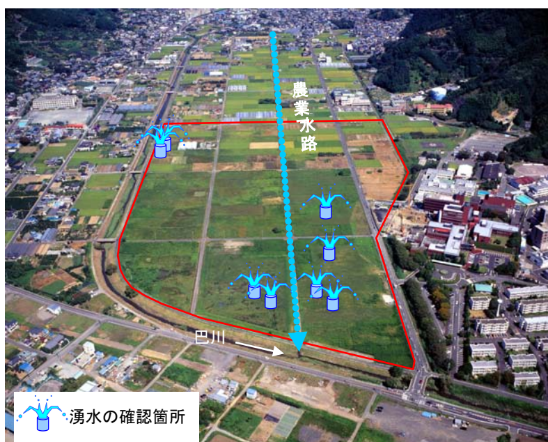
図 1-29.第1工区の湧水確認箇所
