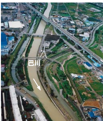
図 1-18. 狭窄部改修後の巴川 (高部水辺公園付近)
