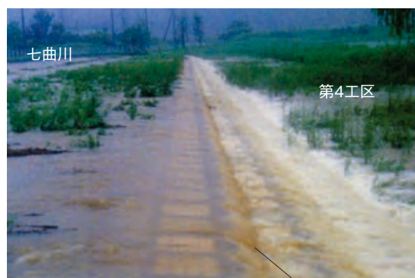
▲七曲川からの越流（第4工区） 越流堤
