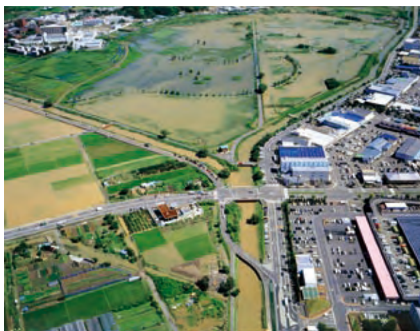
▲平成14年7月11日 台風6号による洪水の状況
