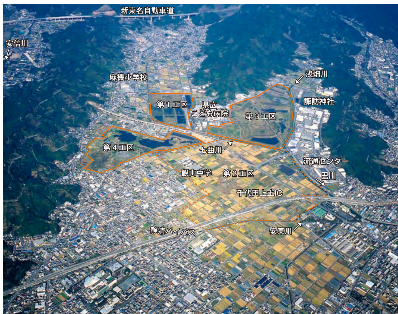
●麻機遊水地全景（平成21年10月28日撮影）
